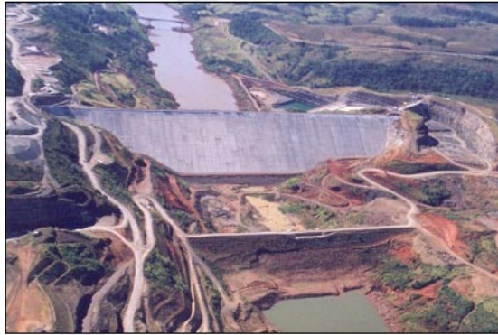
Gradnja hidroelektrarne za oskrbo industrijskih obratov
